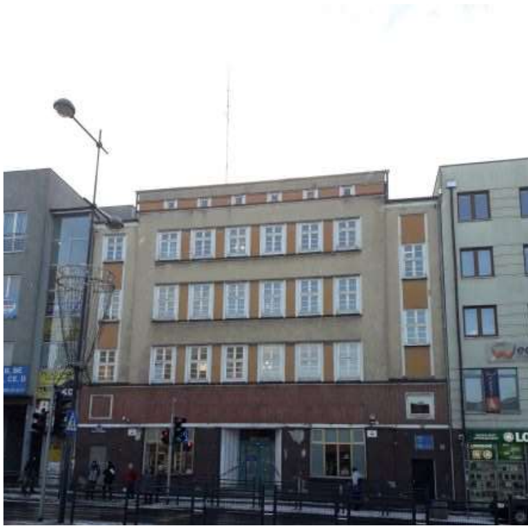
Budynek administracyjno-biurowy, ul. Wyszyńskiego 24
